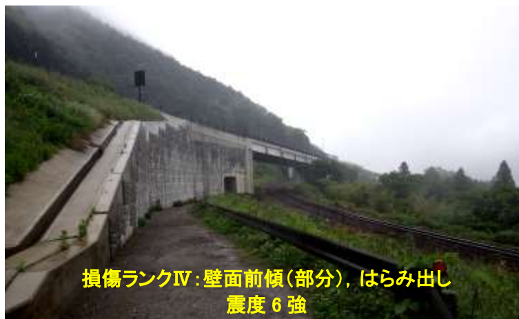
写真-2 特徴的な構造(橋台)の状況
