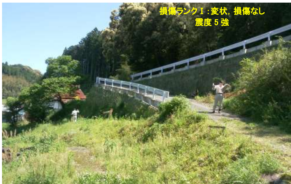
写真-7 緑化壁面材の状況
