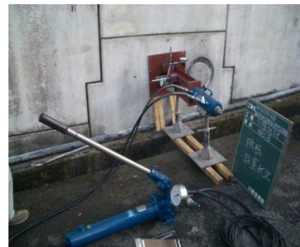
補強材引抜確認試験
