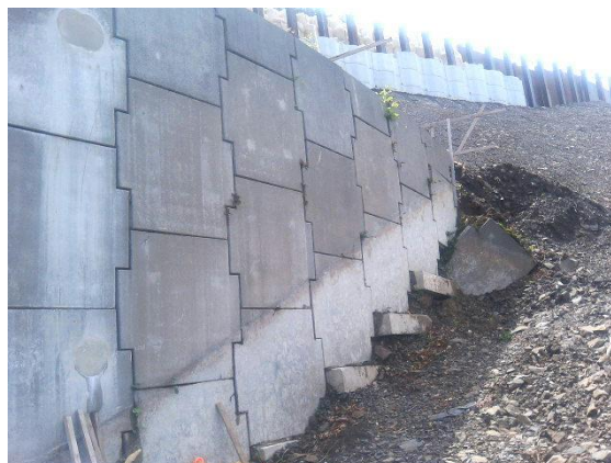
修復工事施工中
