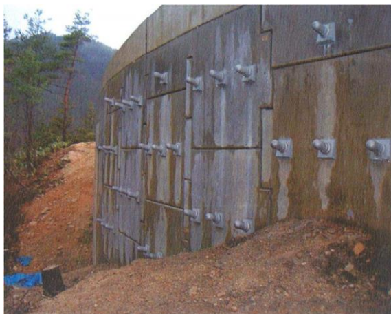
アンカー・ネイリングによる補強
