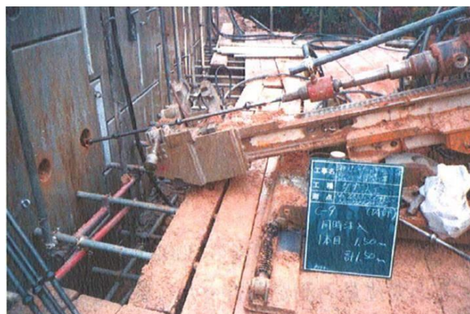
ネイリング打設状況
