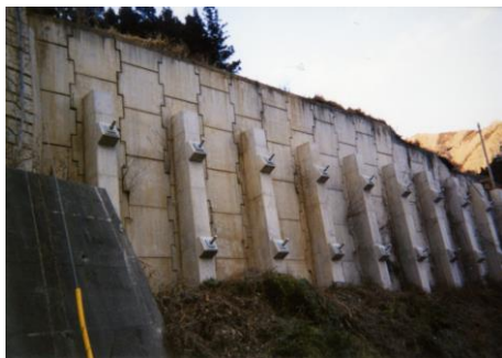
アンカー・ネイリングによる補強
