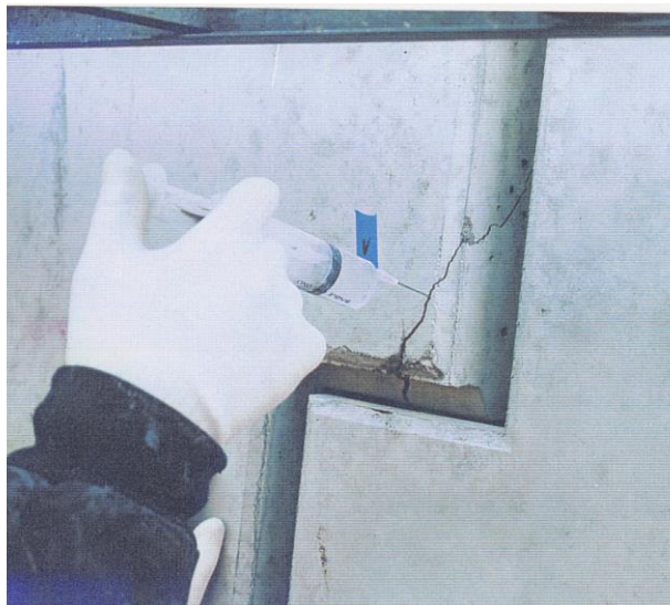
補修材注入例
