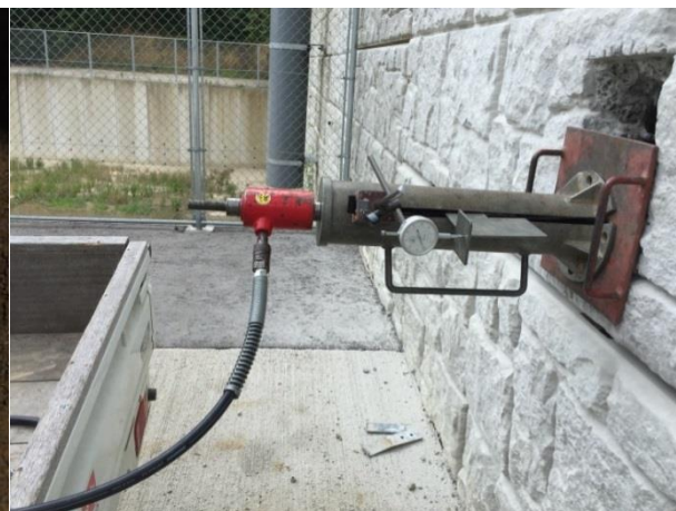
引抜試験の状況
