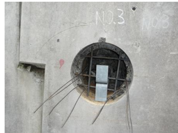
引抜試験後の 補修状況
